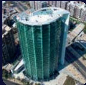
Oficinas CChC Apoquindo/Las Condes
